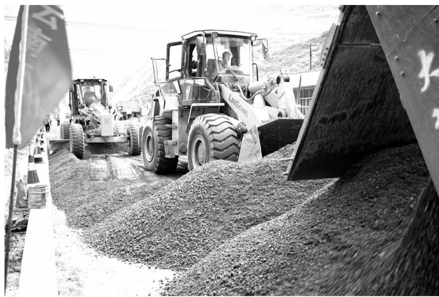
▲ 近日,虎香公路路面级配碎石底基层试验及水泥稳定碎石基层路段顺利铺筑,打响了虎香公路路面施工第一炮,为后续工作的开展奠定了坚实基础。(马建军 摄影报道)
